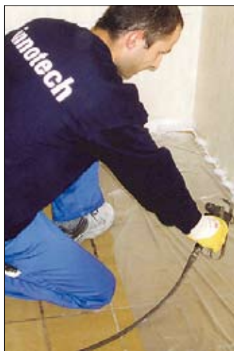
Modernste Abdichtungsverfahren garantieren höchste Qualität.
